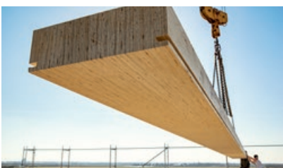
Decken- und Dachelemente aus STEICO GLVL R Furnierschichtholz
