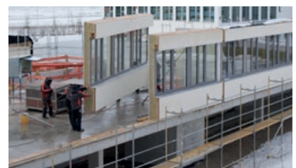
Die vorverputzten Wandelemente werden inklusive Fenster montiert.
